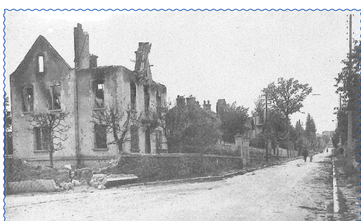
Avenue Ventadour, on y voit clairement toutes les villas détruites - Fonds privé
